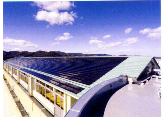
校舎屋根に40kWの太陽光パネルを設置 (静岡県湖西市立岡崎中学校)
