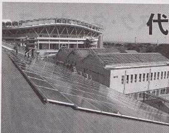
鹿嶋市立カシマスポーツセンターの屋根
