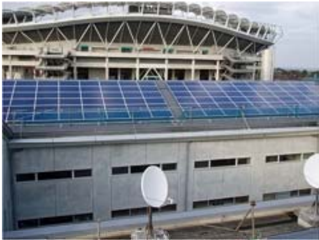
カシマスポーツセンター Sports Center (372.6kW)
